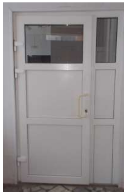
Фото № 12 Дверь входная
