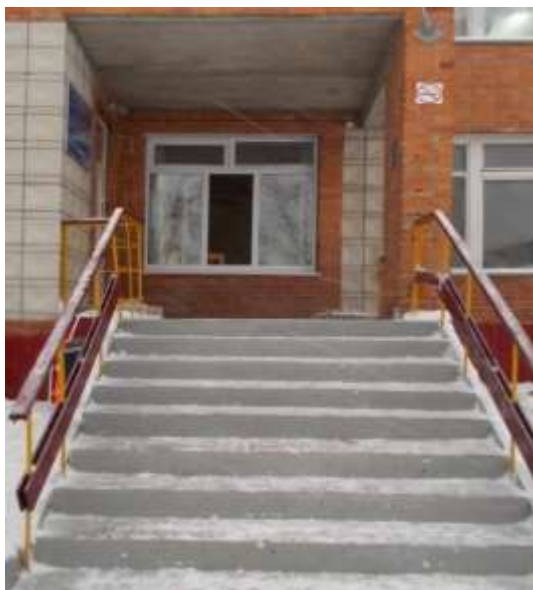
Фото №1 Лестница наружная на территории прилегающий к зданию
