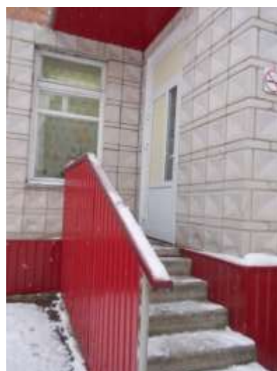
Фото №14 Запасной выход с группы 1-этаж
