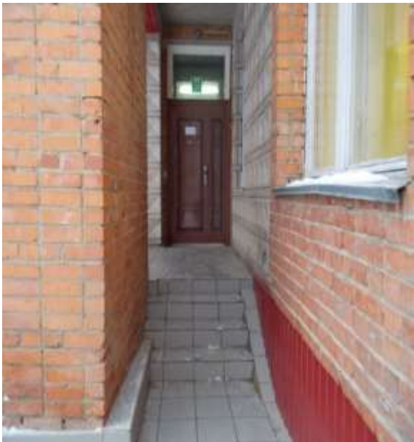
Фото№10 Лестница наружная на территории прилегающий к зданию
