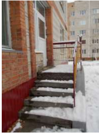
Фото №18 запасной выход 1-этаж
