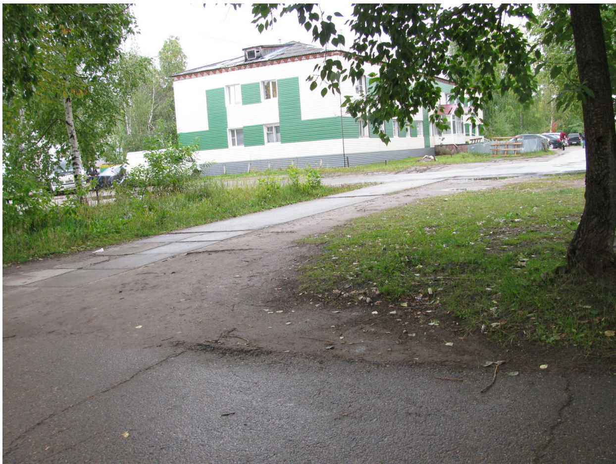
Фото 2 – Не регулируемый пешеходный переход ул.Строителей.
