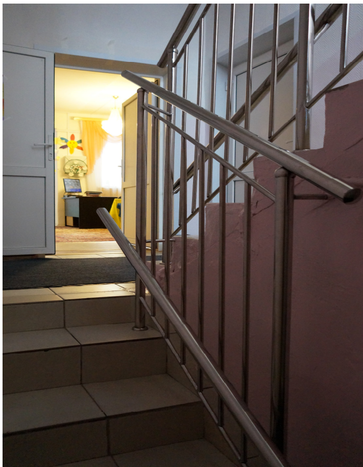
Фото 18 – Вход №1. Лестница вход на 1 этаж ОСИ. Установлены поручни и ограждения.
