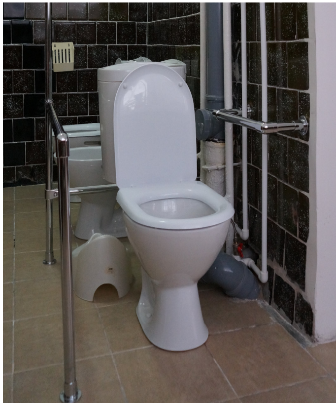
Фото 26 – Подход к унитазу доступен, оборудован поручнями.
