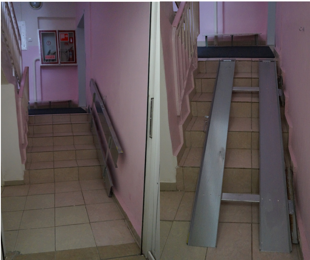
Фото 20 – Лестничная клетка входа №2 оборудована откидным пандусом.
