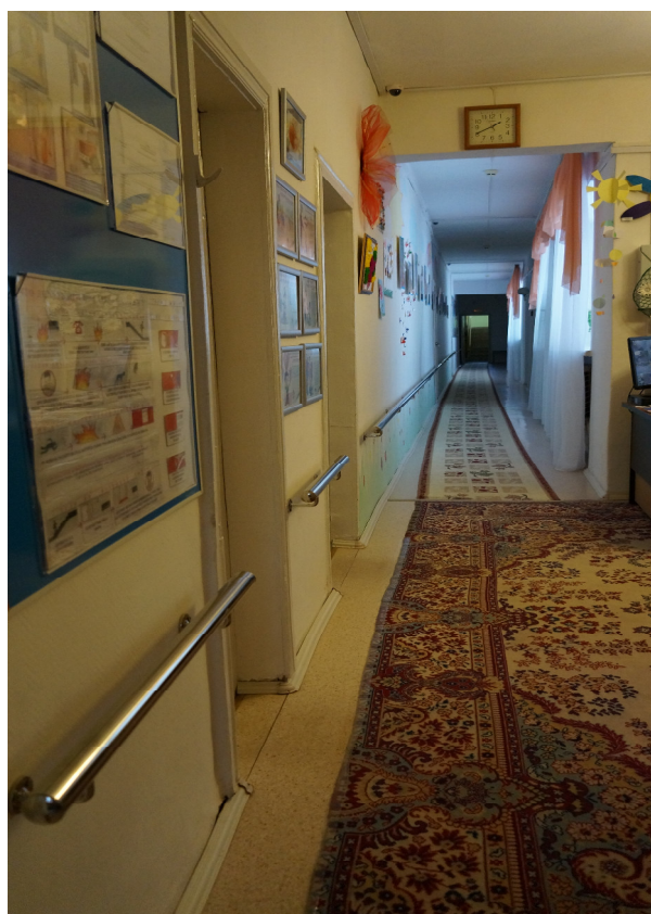
Фото 21 – Коридор 1 этажа по всей длине с одной стороны оборудован поручнями.
