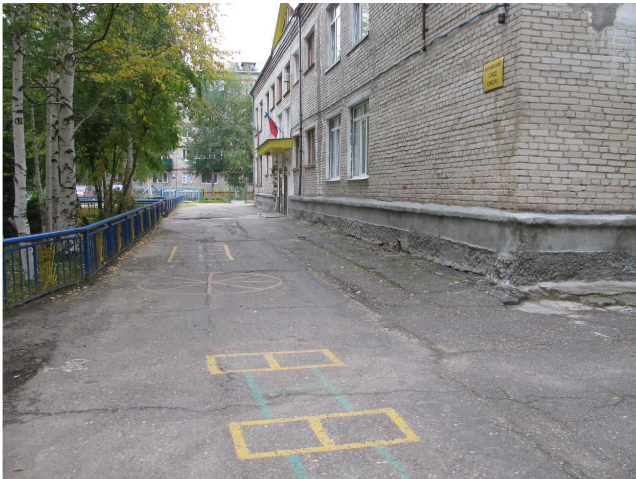
Фото 11 – Территория, прилегающая к зданию. Асфальт с неровностями и выбоинами.
